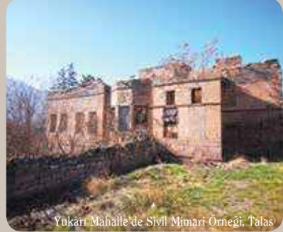
Yukarı Mahalle'de Sivil Mimari Örneği, Talas
